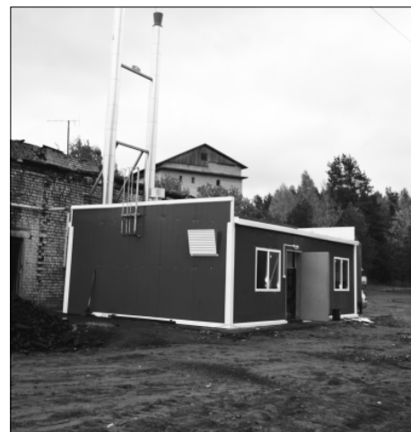
Вместо угольной котельной, принадлежащей ЦРБ, построена новая — газовая.
