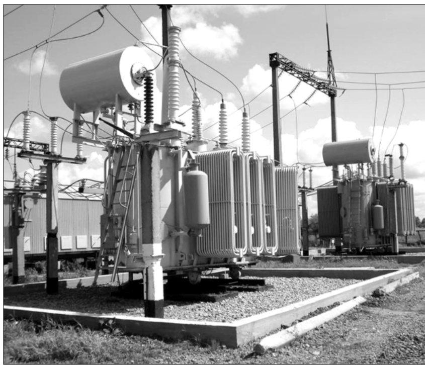
Подстанция «Радуга» в Кимрах после капитального ремонта.
